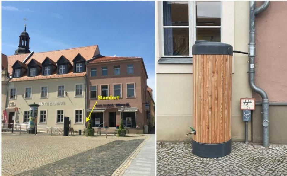
Abb. Blick auf Fassade und Dachflächen des Bürgerhauses mit straßenseitigem Fallrohr// installierte Pilot-Wassertanke
